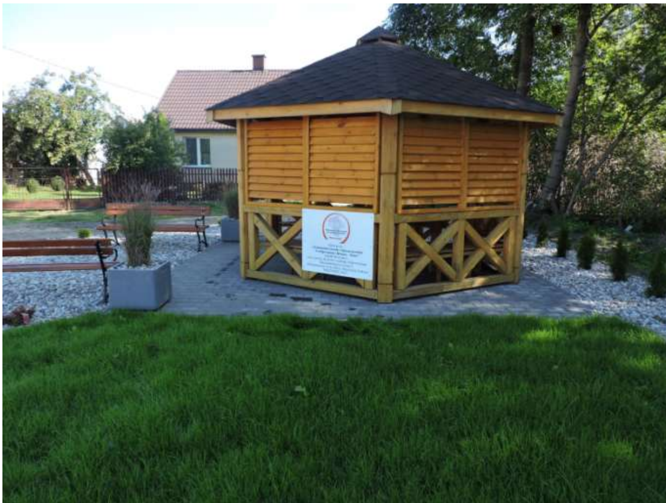
ZDJĘCIE PO REALIZACJI ZADANIA
