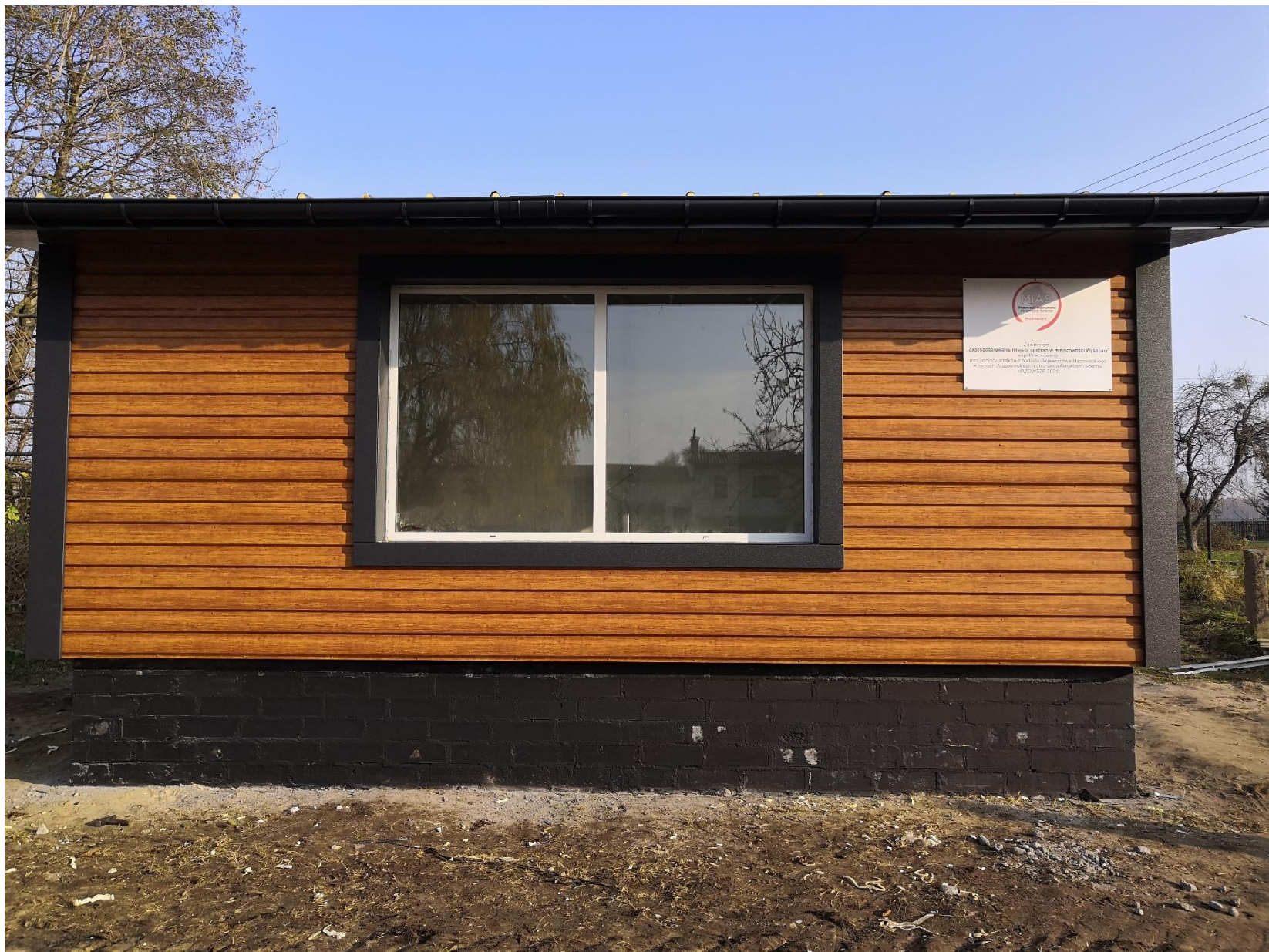
Zdjęcie po realizacji zadania
